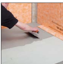
do 6. Nanieść zaprawę cienkowarstwową
