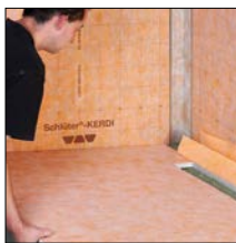
do 3. Wsunąć płytę spadkową pod krawędź korpusu rynny
