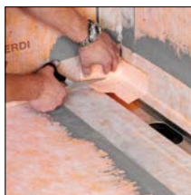
do 2. Przykleić manszetę KERDI/ dociąć narożnik wewnętrzny KERECK
