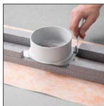
do 3. Ponownie przykręcić adapter
