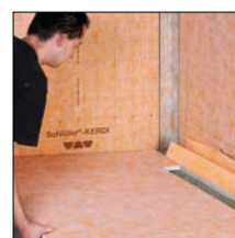
do 3. Wsunąć płytę spadkową pod krawędź korpusu rynny
