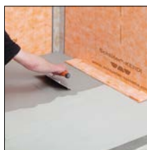
do 7. Nałożyć zaprawę cienkowarstwową
